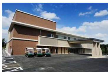
沖縄カントリークラブ クラブハウス外観
