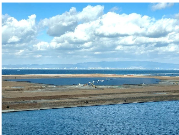
関西国際空港 太陽光発電システム (2期島北側土地)
