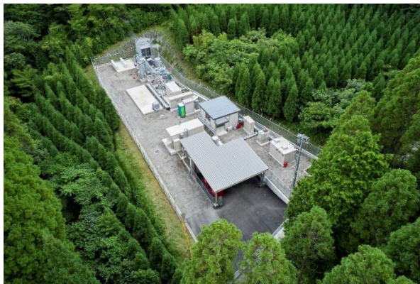
地熱発電所を含む水素製造サイト外観 (写真提供：株式会社大林組)
