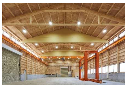
木造技術研究所内「構造実験棟」 500㎡超の無柱大空間の木造建築
