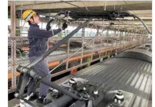
パンタグラフ打音検査の様子（イメージ）
