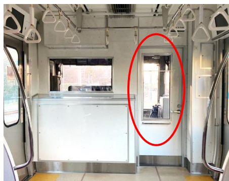
《仕切り窓改造後》
