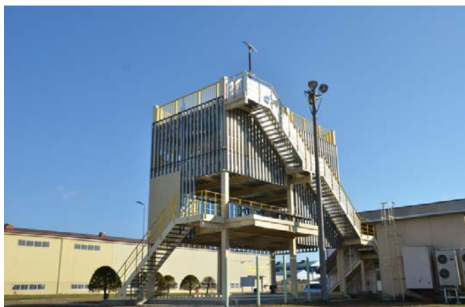
津波避難タワー（セーフガードタワー）
