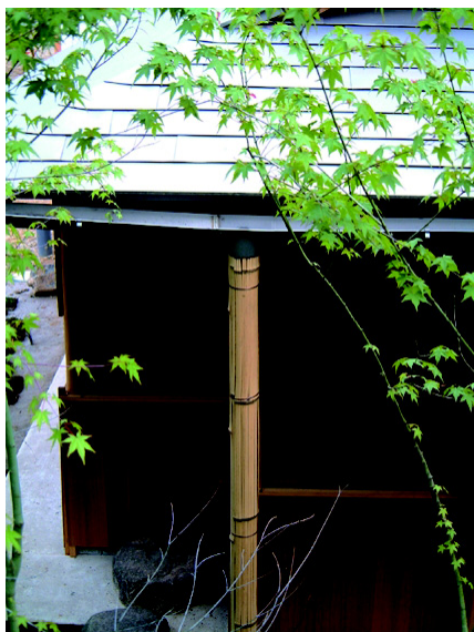
写真 1：金閣寺茶室（常足亭）
