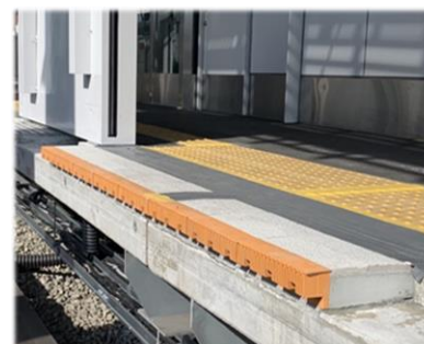
《転落防止ゴムの整備》
