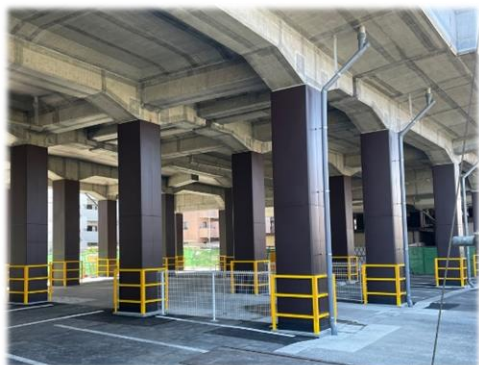
《高架橋耐震補強》
