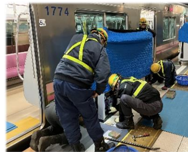
《搬入・設置の様子》
