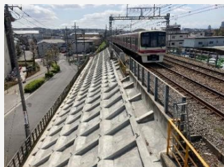
法面耐震補強
