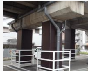
高架橋耐震補強
