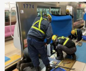
搬入から設置
