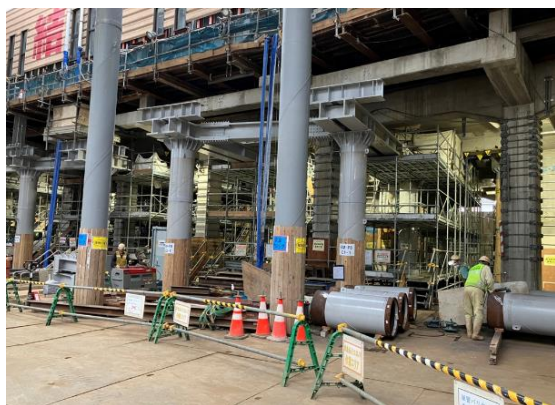
&lt;高架橋仮設化の工事状況&gt;
