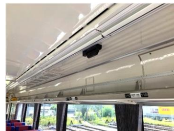
＜設置した車内の様子＞
