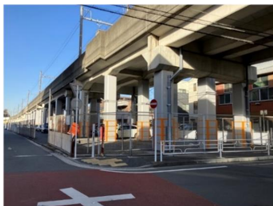
＜高架橋耐震補強工事例（弘明寺～上大岡駅間）＞
