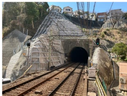
＜法面防護工事例 （汐入～横須賀中央駅間 21 号隧道浦賀方坑口）＞
