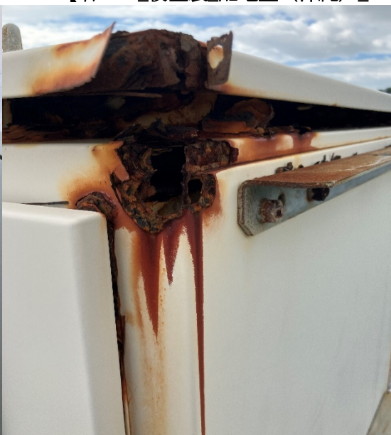
【右：GA 後塗装 配電盤 (沖縄) 14 年後
