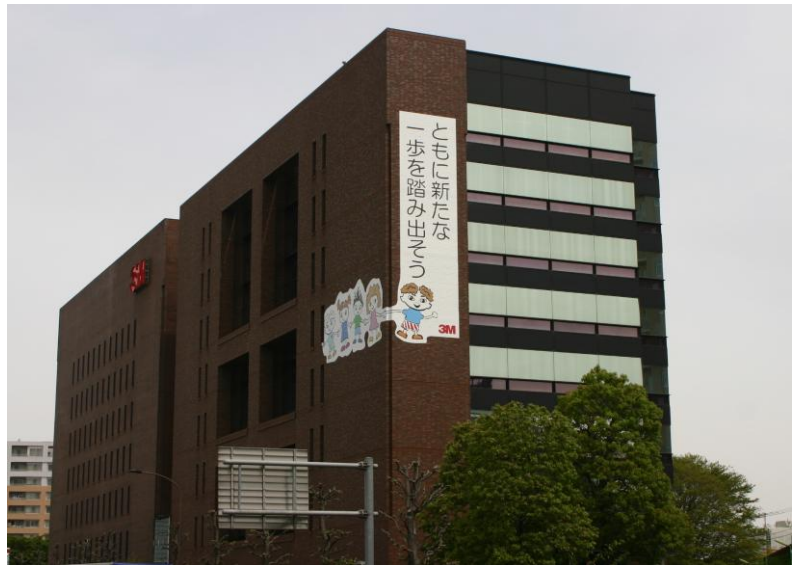
環状8号線沿いに建つ本社ビル。 南面と西面にまたがって掲示しました。
