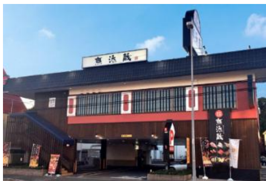
伊丹昆陽店(兵庫県伊丹市)
