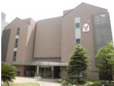
日本第一号「せたがやハウス」外観
