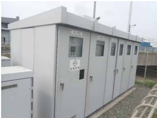
〔図1〕キュービクル（高圧受電設備）
