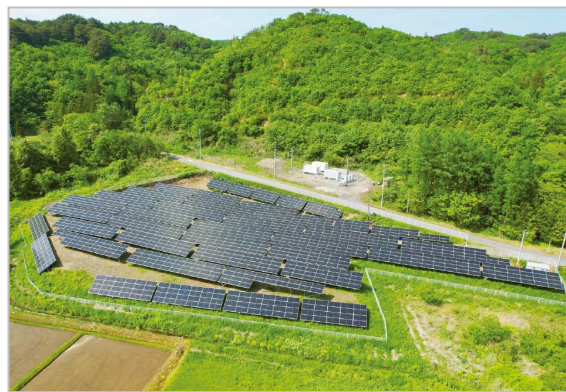
運転を開始した太陽光発電設備
