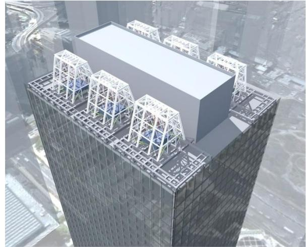
超大型制震装置TMD
