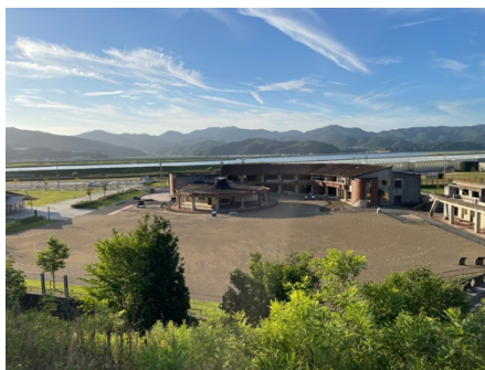
震災遺構 大川小学校
