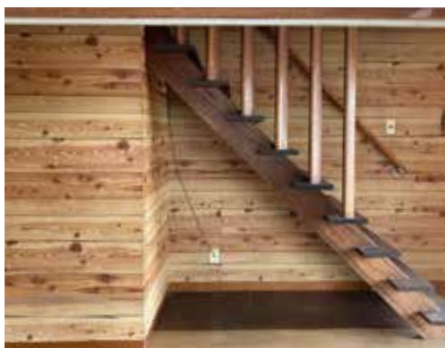
玄関ホールにあった改修前の階段。現在はリビング階段に変更されており、LDK空間をより広く有効に活用している。
