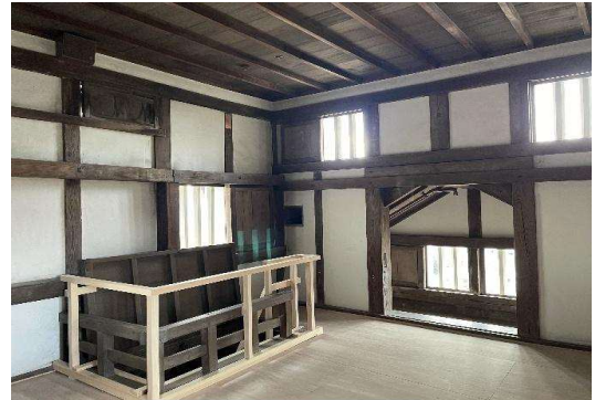
▲西小天守 3 階内部
