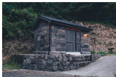
大日 止昂小水力発電所
