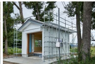
（写真：2025 年 10 月に完成した家屋訓練棟）
