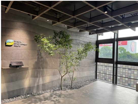
【6階エントランスの版築壁とシンボルツリー】
