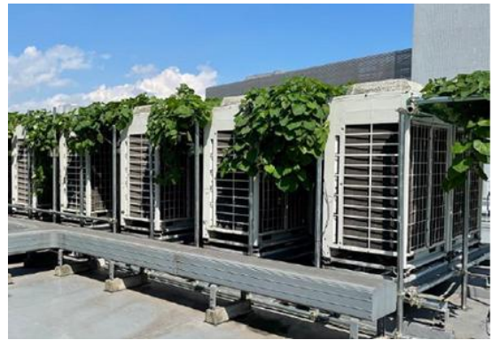
オフィスビル屋上の芋緑化
