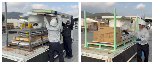
（左）従来の梱包と積み方（右）新しい梱包と積み方により、荷下ろし作業がしやすくなり現場での作業負担軽減に
