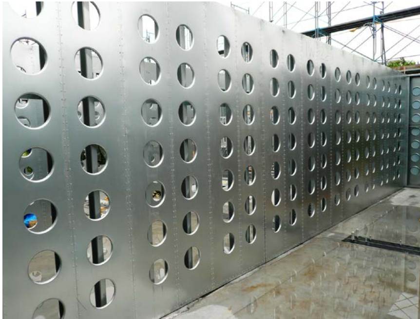
「高強度の耐力壁」(大分製鐵所明野北社宅建設現場)
