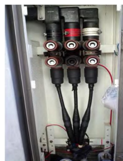
（図2）点検により事故未然防止に至った MDS（出典：電気保安法人より提供 ※b ）
