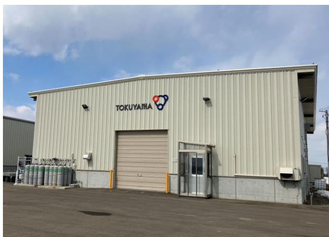
株式会社トクヤマ「太陽光パネルリサイクル実証試験施設」
