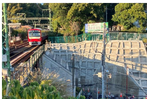
<法面防護工事例（杉田～京急富岡駅間）>
