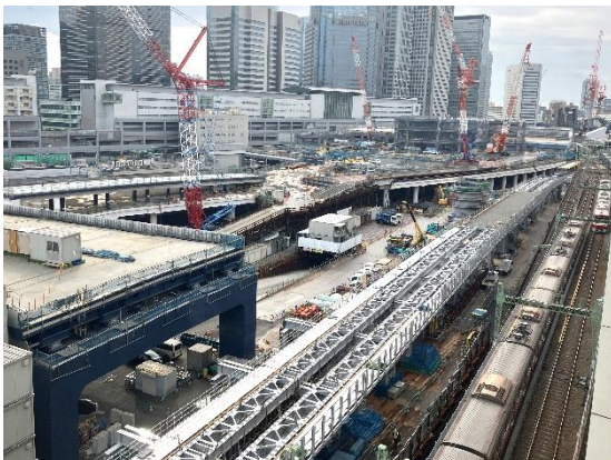
< 仮線高架橋の構築状況 >
