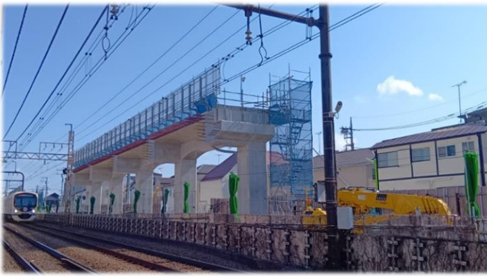
《高架橋躯体(明大前～下高井戸駅間)》
