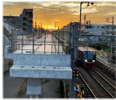
《高架橋躯体(千歳烏山～仙川駅間)》
