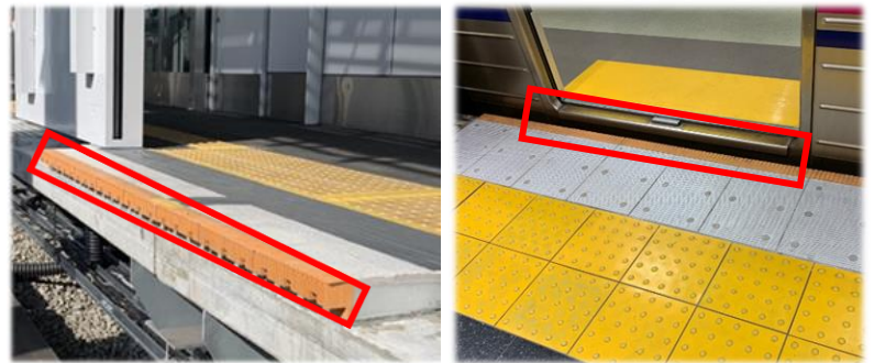
《転落防止ゴム設置の様子》
