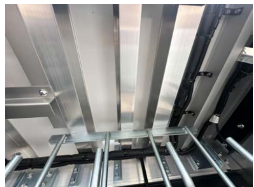
トラック根太部分 （トラック車体の下から撮影）
