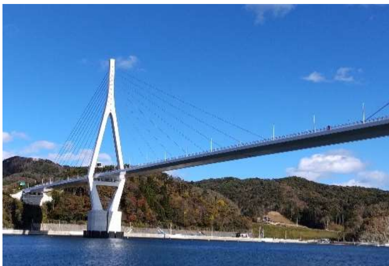
<CORSPACE を使用している橋梁：気仙沼湾横断橋>
