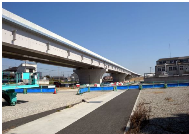
図3 コルスペース適用事例東播磨南北道 (水足新辻第5高架橋)
