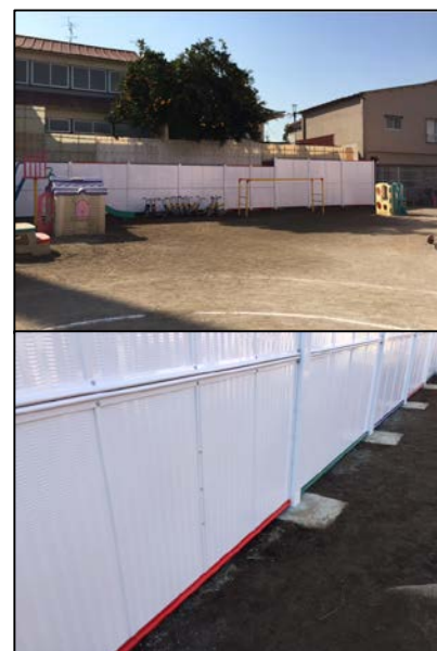
▲設置工事後、描画前の大型フェンス (2016年4月撮影)
