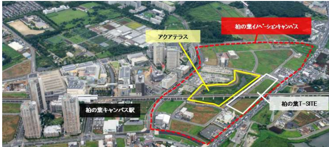
※2015年9月撮影 (アクアテラス施工前)
