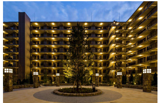
建物外観写真
