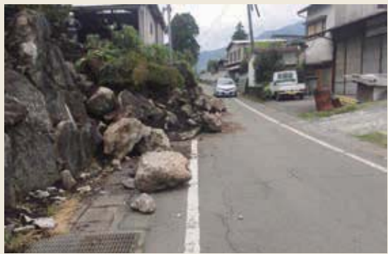
熊本県菊池郡大津町近辺で起こった地震による道路被害
