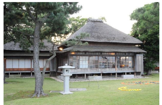
旧伊藤邸外観
