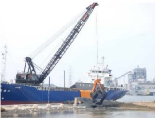
③ 埋立材の投入状況
