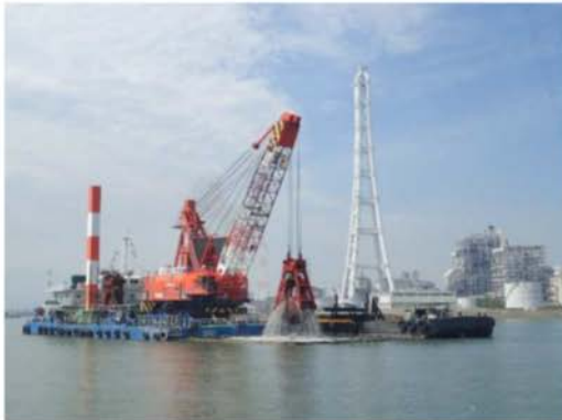
① 浚渫状況
