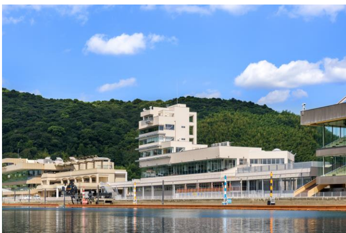
< 新中央スタンド全景（水面側） >
