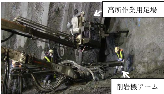
写真1 次施工の鋼管をアームに載せている状況（従来工法）
