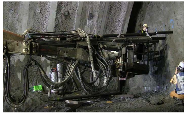
写真2 鋼管接続状況（新工法）
