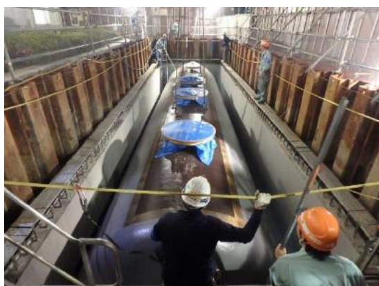
非常用発電機設備のオイルタンク設置
