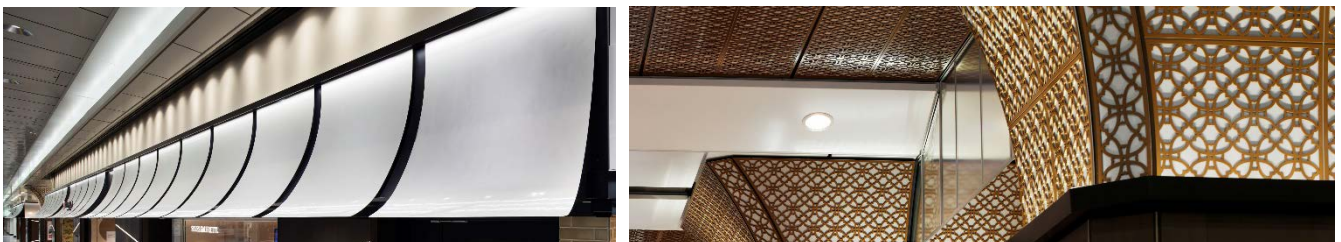
再生アルミニウムは、「のれん」をイメージしたファサード（写真左）や「桜の花びら」をイメージした柱・天井（写真右）だけでなく、商品ケースの骨組み材（柱・梁）にも使用した
