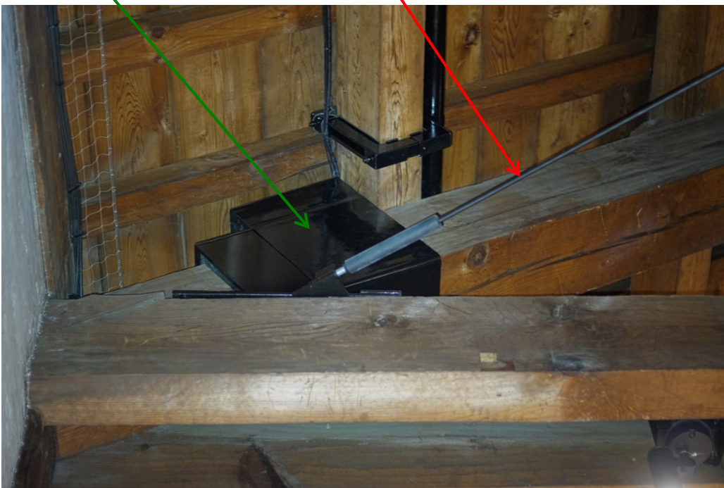
(写真 2)チタン箱工法施工状態 チタン箱(巻付貼付)
