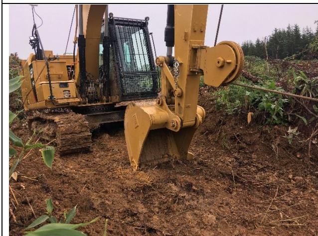
バケットを土につきさして設置。
