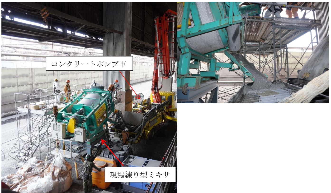
写真2 現場練り型ミキサから排出されるジオポリマーコンクリート
