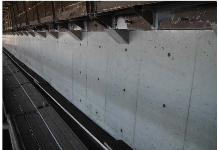
写真1 施工後の擁壁 (長さ 24.7m×高さ 1.3m×厚さ 10cm)
