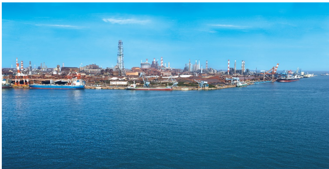
製鉄所の海べり設備・超高煙突（鹿島地区全景）
