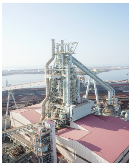
超高層建築物（和歌山地区 第2高炉）
