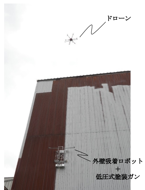
図2：実証試験中の様子（塗装状況）
