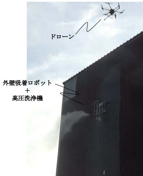
図 3：実証試験の様子（高圧洗浄状況）
