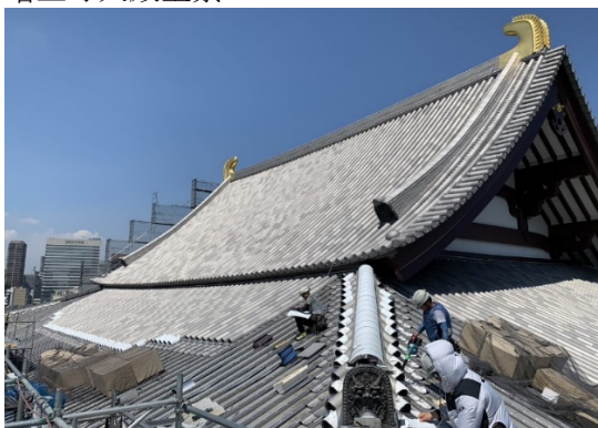
増上寺大殿屋根工事全景
